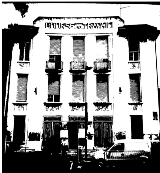
Bourse du Travail de Toulouse construite en 1892 et agrandie en 1931 (Place Saint-Sernin)
